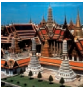
Bangkok:Grand Palace バンコク/王宮 1782年にラマ1世がチャクリ王朝を興すとともに建設が始まる。白い壁に囲まれた20万m 2 の敷地内には、歴代の王が造った数々の宮殿があり、ワット・プラ・クオもこの敷地内にある。
